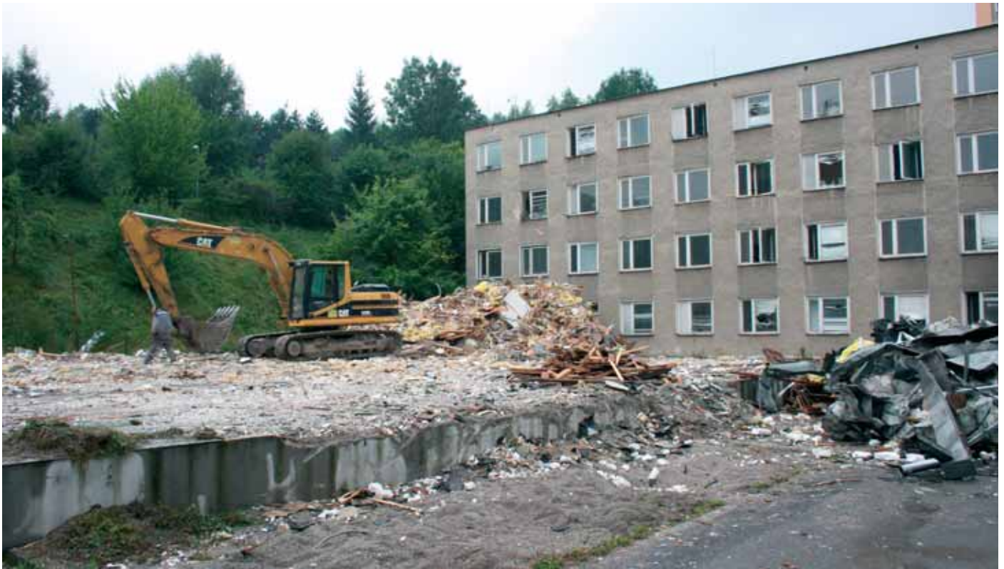
Práce na výstavbe novej Univerzitnej knižnice KU začali.
