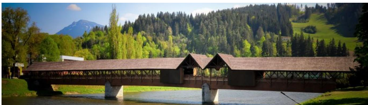
Obrázok.6 Drevený kolonádový most v Dolnom Kubíne (zdroj: https://dolnykubin.com/wooden-colonnade-bridge/ )
