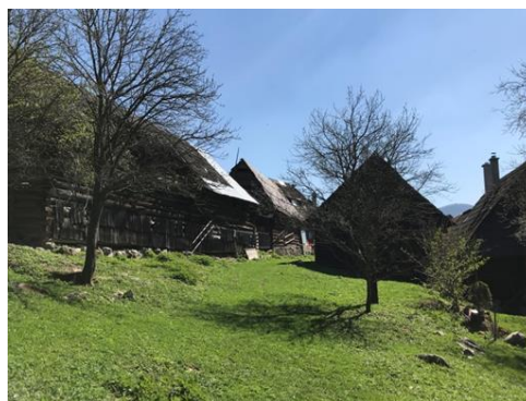
Obr. č. 4 Hospodárske budovy
