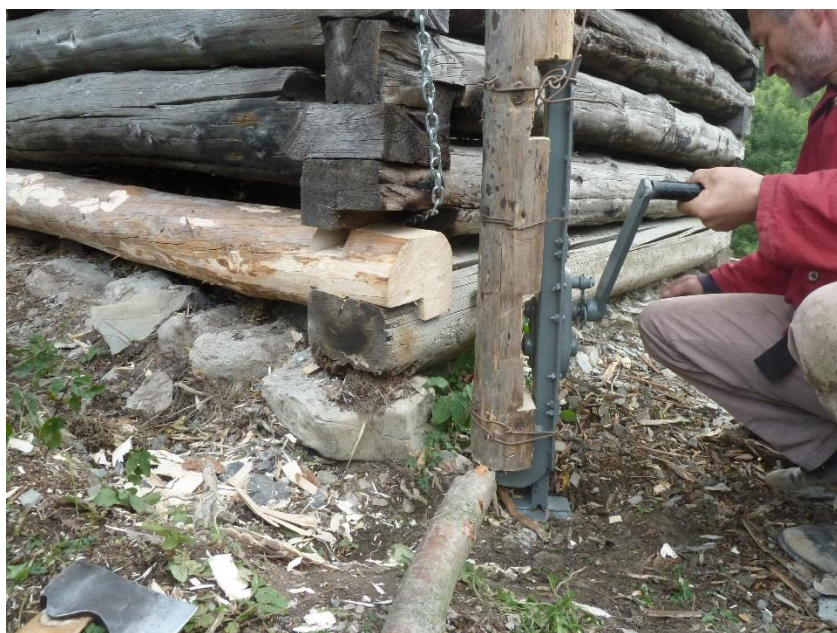
Obr. č. 6 Výmena odhnitého spodného dreva (foto Boris Hochel)
