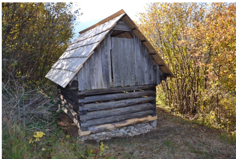
Obr. č. 2 Vlkolínsky senník po obkopení, výmene spodných brvíen a s novou šindľovou strechou (foto Boris Hochel)
