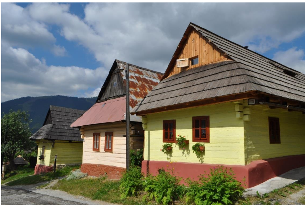
Obr. č. 7 Typické trojpriestorové zrubové domy (foto M. Dudáš)
