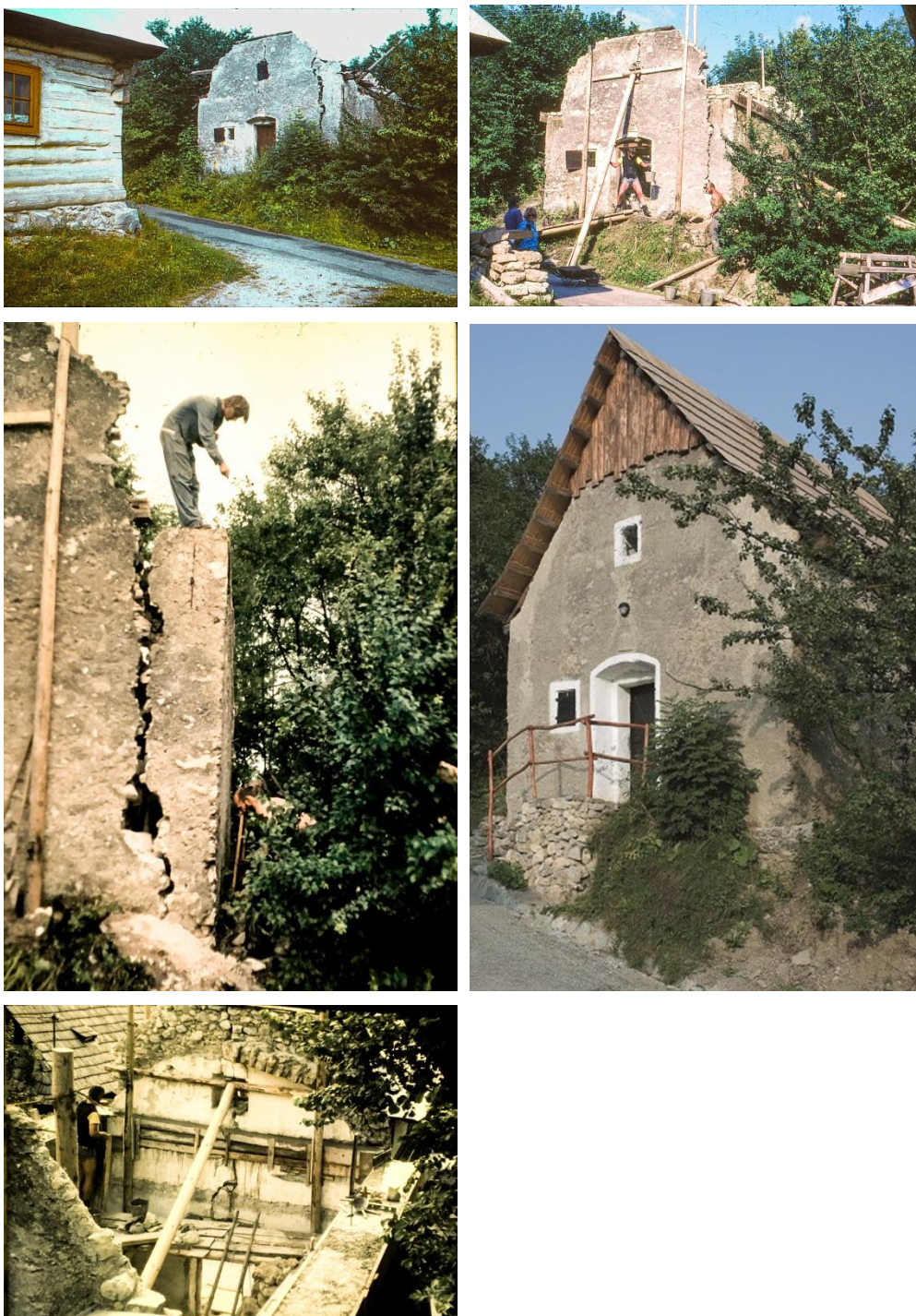
Obr. č. 11 – 15 Prvá etapa generálnej opravy sýpky v dolnej časti obce.
