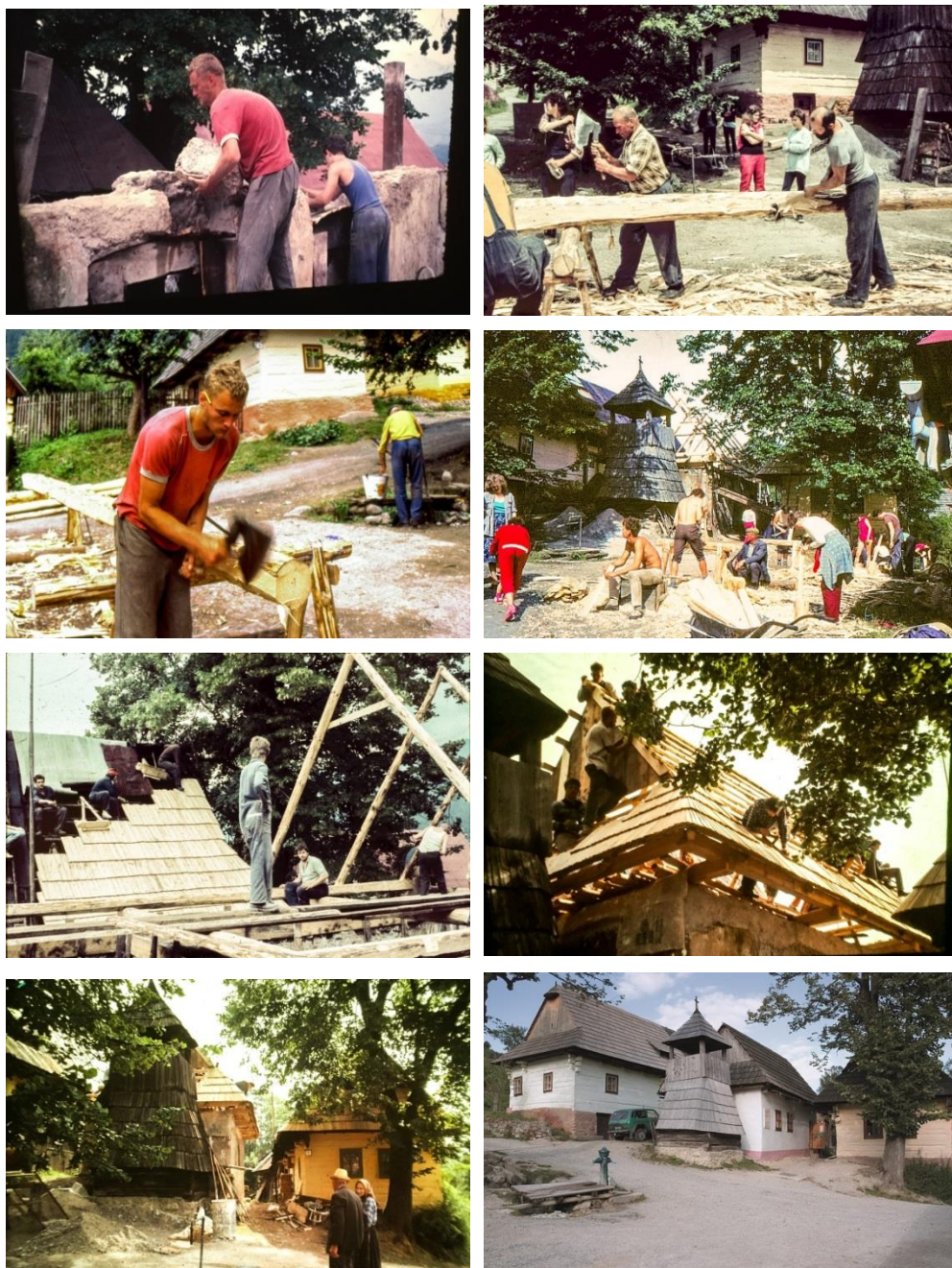
Obr. č. 1 – 10 Postup generálnej opravy centrálneho objektu pri zvonici v centre Vlkolínca. Premena z ruiny na obytný objekt v ktorom neskôr sídlila Správa Vlkolínca. V súčasnosti opäť chátka.
