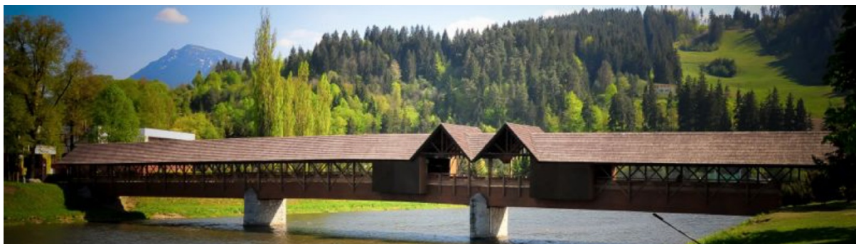
Obrázok.80 Drevený kolonádový most v Dolnom Kubíne (zdroj: https://dolnykubin.com/wooden-colonnade-bridge/ )
